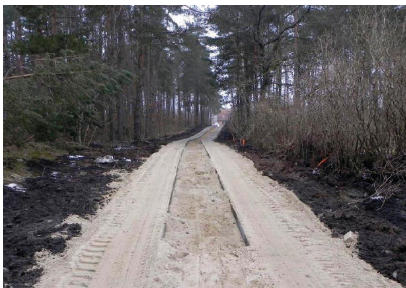
Zmodernizowana droga w Sztumskim Polu.
