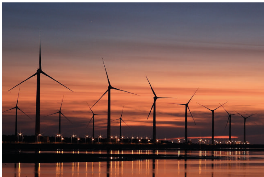
W ramach programu zostanie wykonana analiza budowy nowych źródeł odnawialnych oraz magazynów energii.
