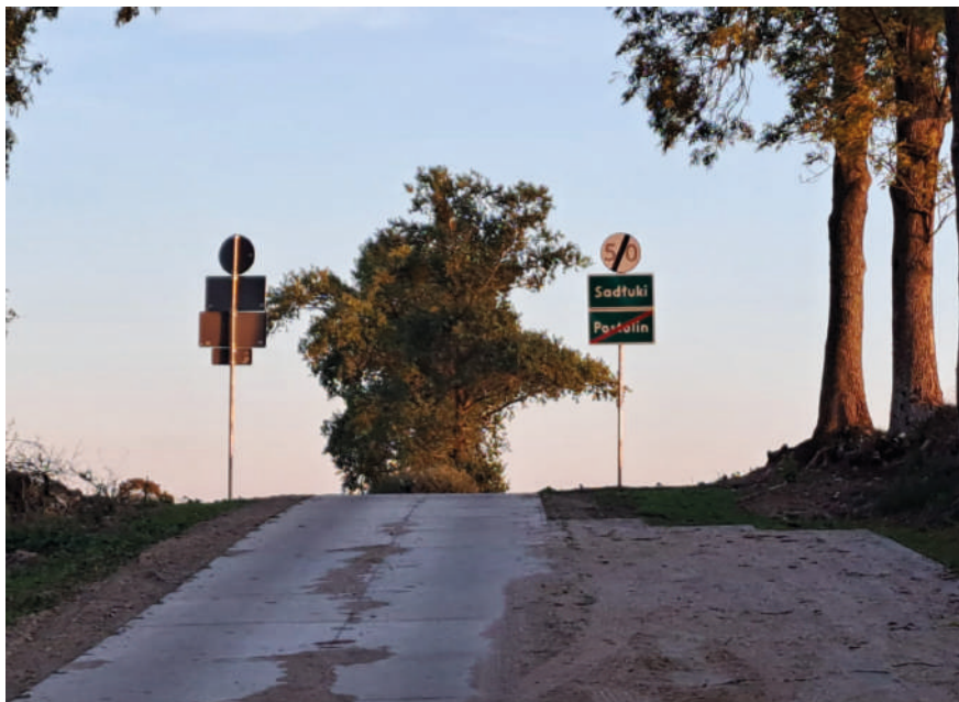
Zmodernizowana droga gminna w Postolinie.
