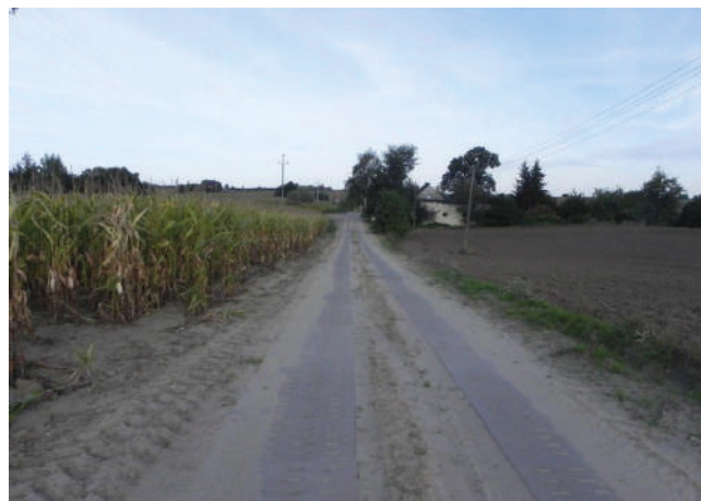
Utwardzony odcinek drogi w Gościszewie.
