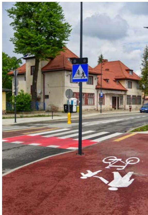
Dopełnieniem inwestycji byłby remont budynku dworca.
