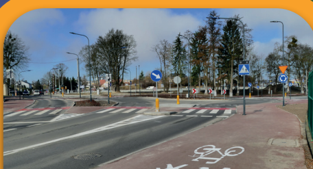
Budowa Węzła na finiszu
